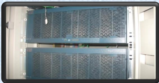
تجهیزات شبکه دیتا
